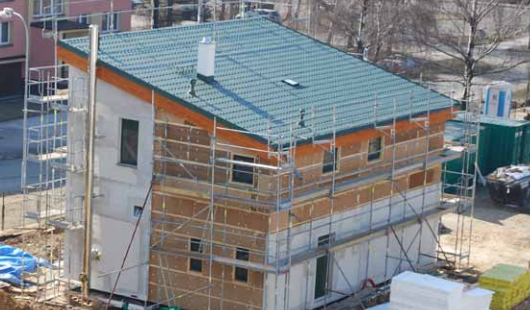
▲ Pohled na hrubou stavbu budovy
